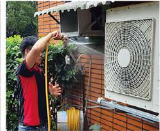
廠商清洗1~2F冷氣設備
