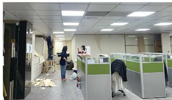
開放辦公區水電工程
